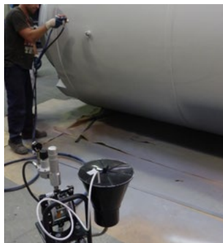
Réservoir de gravité
